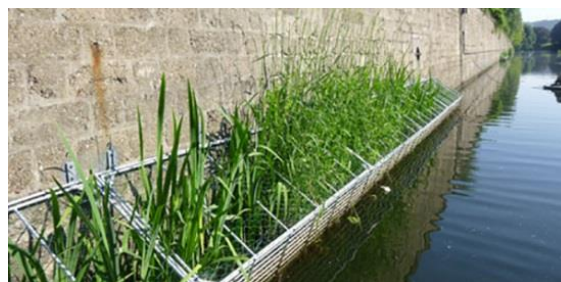
Fascines sur la Meuse à Liège © Maison Wallonne de la Pêche
