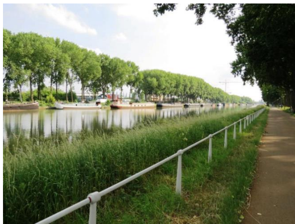
Bassin de Batelage
